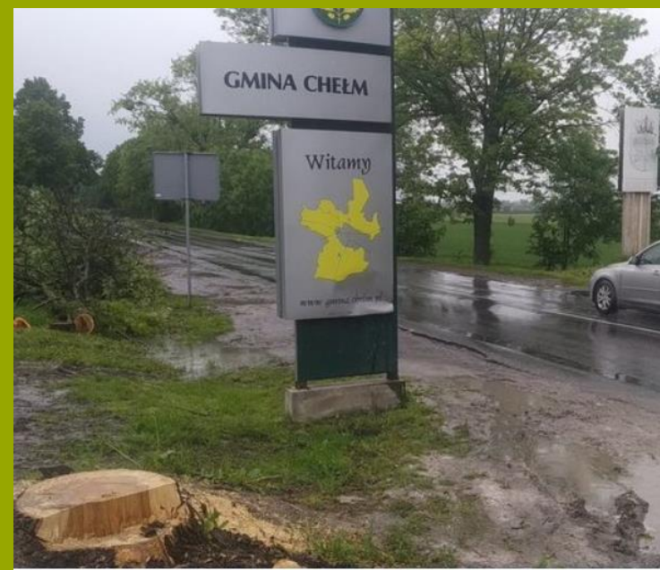
Budowa drogi rowerowej wzdłuż drogi nr 844 z Chełma-Hrubieszowa
