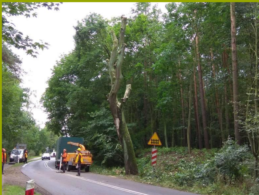
Budowa ścieżki rowerowej wzdłuż ulicy Poznańskiej i modernizacja drogi w Puszczykowie
